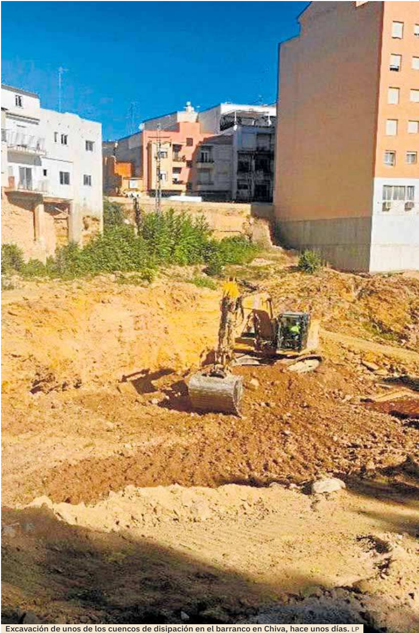
Excavación de unos de los cuencos de disipación en el barranco en Chiva, hace unos días. LP
