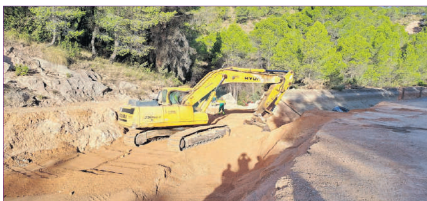
La reparación ha requerido de la reconstrucción completa del tramo afectado.
